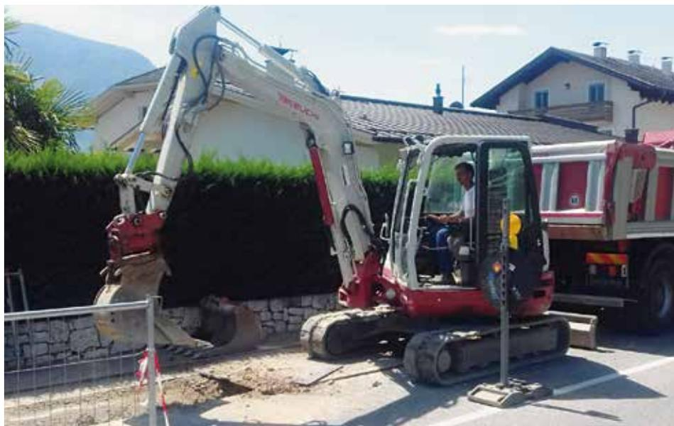
In der Weinstraße wurden vor gut zehn Jahren im Zuge der Erneuerung der Trinkwasserversorgung alle nötigen Leitungen und Kabel verlegt; jetzt kamen Heizrohre dazu. hgk
