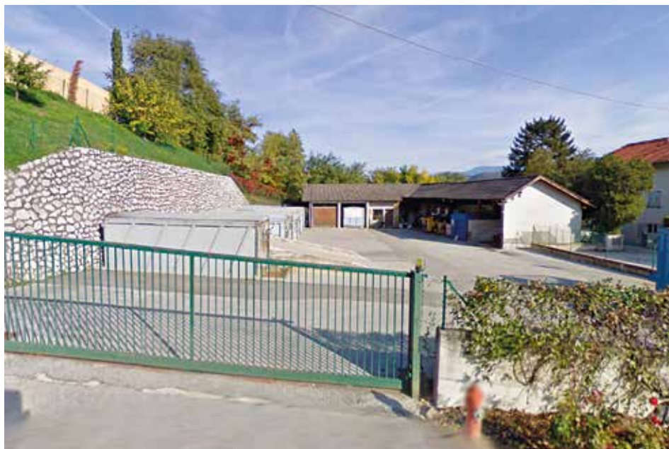
Der alte Wertstoffhof ist in die Jahre gekommen und entspricht nicht mehr den gesetzlichen Normen. Über den Standort für einen neuen Anlage wird zurzeit diskutiert.
