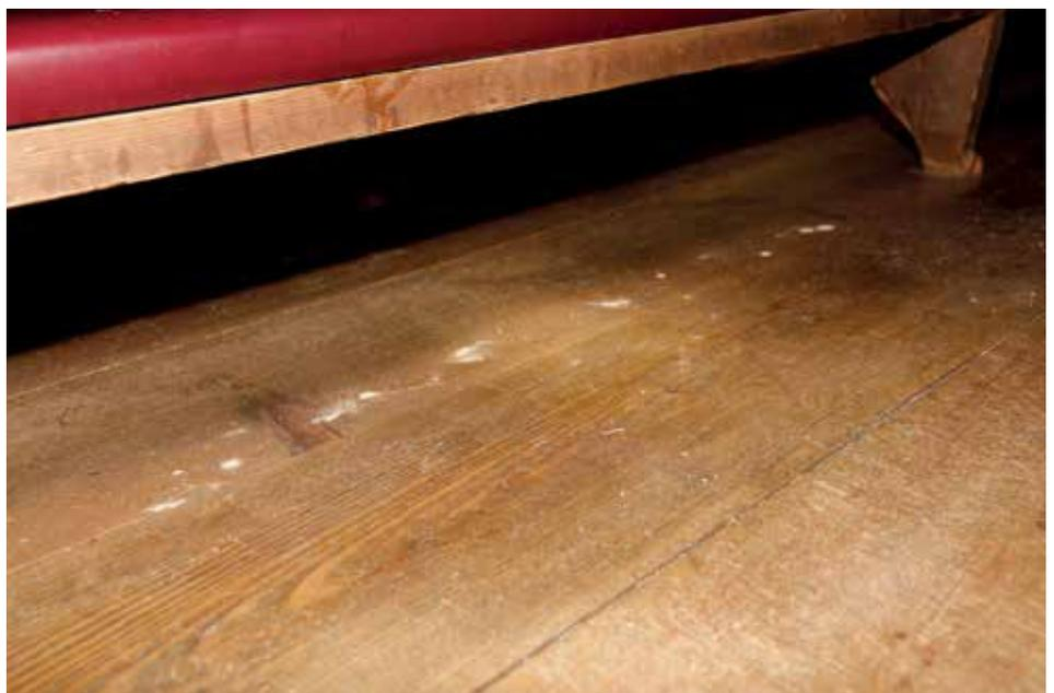
Der Schaden ist bereits groß. Der Holzboden ist von den Schädlingen geradezu durchlöchert.
